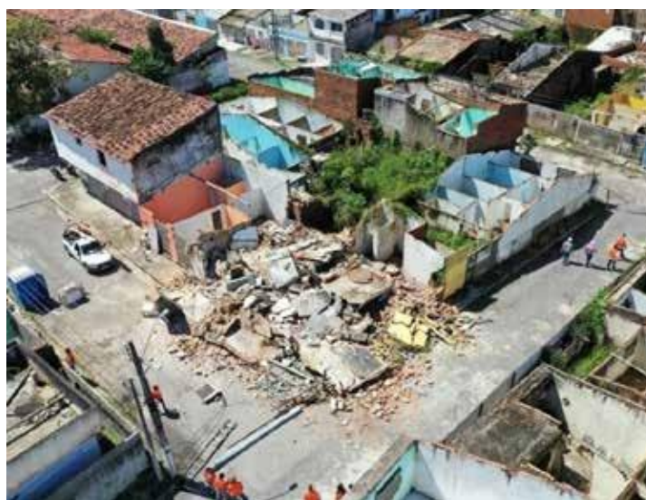
Figura 2 – Imagem de demolição de estruturas condenadas no bairro do Pinheiro
