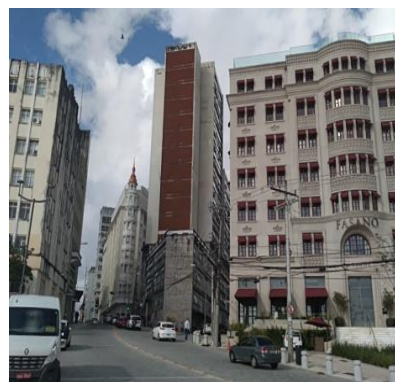
Foto 1 - Rua Chile. Hotel Fasano e no fundo Fera Palace
