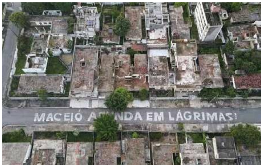
Figura 3 – Foto de intervenção realizada por artistas locais, como expressão dos danos causados pelo desastre
