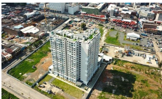
Foto 4 - Conjunto residencial Cidade Paraíso
